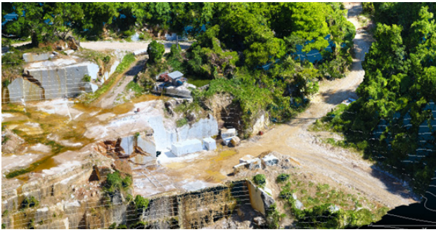
Figura 6. Vista geral da área estudada, onde se percebem curvas acentuadas e ângulos de visão inadequados para os motoristas.
