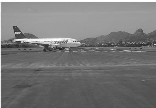
Figura 11. Base do “stop way” construído com acerita (Pista de pouso e decolagem do Aeroporto Internacional de Vitória – ES)
