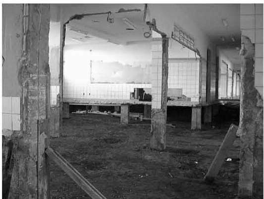
Figura 2. Aterro de Escória de aciaria LD retirado devido problemas de expansão – local: Coopeduc, Serra (ES)
