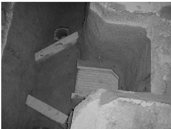
**Figura 2.** Montagem refratária do conjunto *Ripple Pad* e diques no *tundish*.
