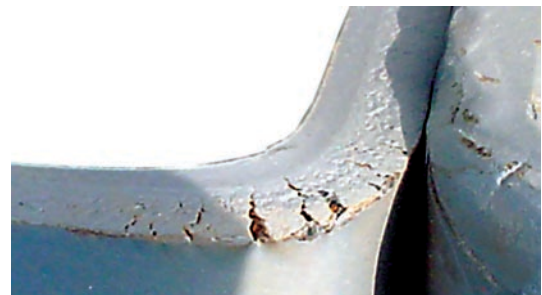
Figura 1. Trincas oriundas do processo de conformação (dobramento) de um aço com alta resistência mecânica.
